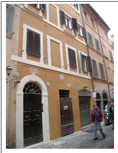
Facciata post operam
