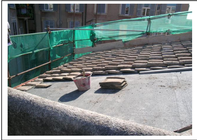
Fase di montaggio copertura
