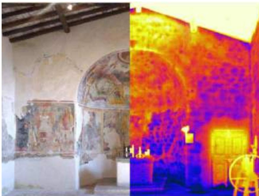
Questa foto composta ( Tradizionale/Termografica ) ritrae una cripta. L'indagine è stata eseguita per rilevare infiltrazioni, fessure, eventuali distacchi di intonaco e la tessitura della sottostante muratura. Le macchie blu nella porzione Termica sono le parti più fredde ma, indirettamente fanno capire come è tessuta la muratura, informazione utile in caso di ristrutturazione/restauro della cripta.
